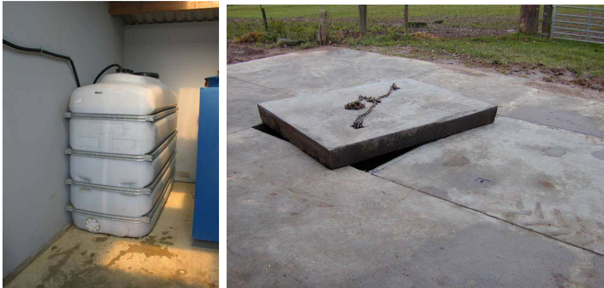
Abb. 18 + 19: Beispiel für einen 4000 l PE-Puffertank und einen unterirdisch betonierten 5000 l Puffertank in der Nähe des Befüll- und Waschplatzes mit Separierungsventil für Regenwasser (Quelle: pcfruit)
