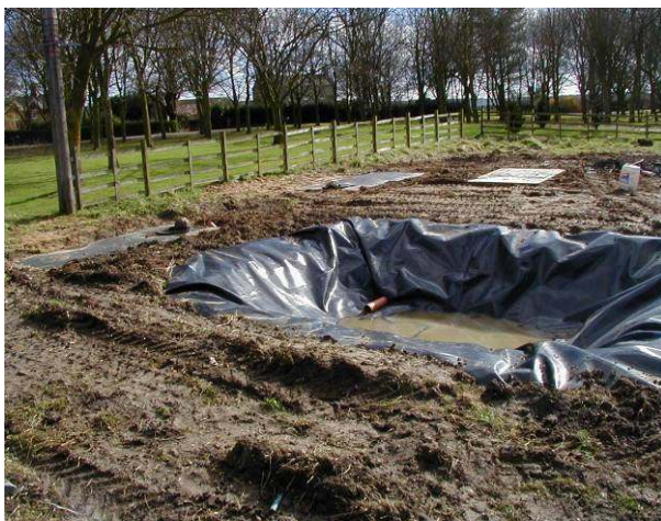
Abb. 25 + 26: Eine Alternative zu Beton stellen Plastikfolien wie EPDM (links - Foto: ADAS) und PE-Kisten/Container (rechts - Foto: Mybatec) dar.
