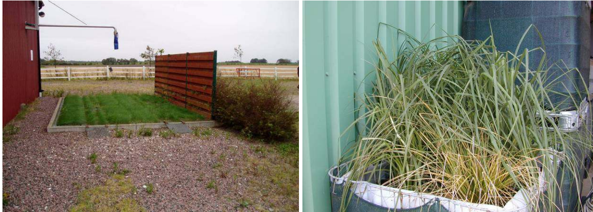
Abb. 28 + 29: Grasschicht auf einem direkt zu befüllenden Biobed (links - Foto: VISAVI) und Carex spp. in der letzten Einheit eines modifizierten Biofilters (rechts - Foto: pcfruit)
