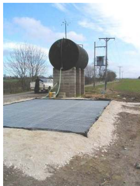
Abb. 12: Überfahrgitter auf einem Biobed
