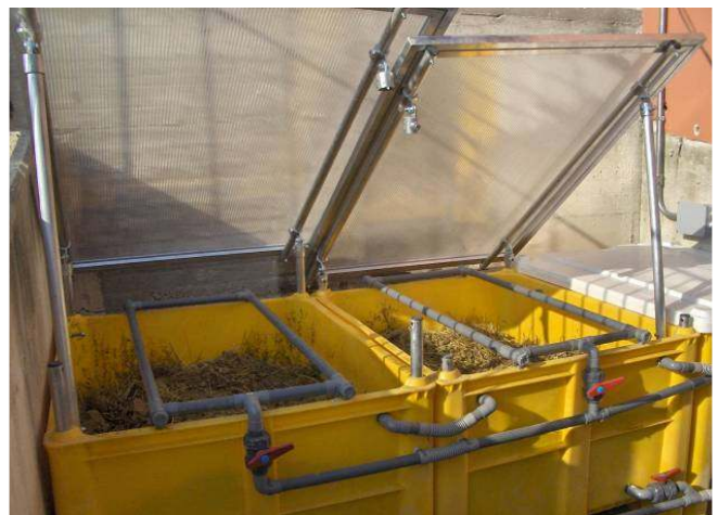
Abb. 25 + 26: Eine Alternative zu Beton stellen Plastikfolien wie EPDM (links - Foto: ADAS) und PE-Kisten/Container (rechts - Foto: Mybatec) dar.
