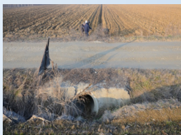
Spływ do rzeki rurami/kanalami
