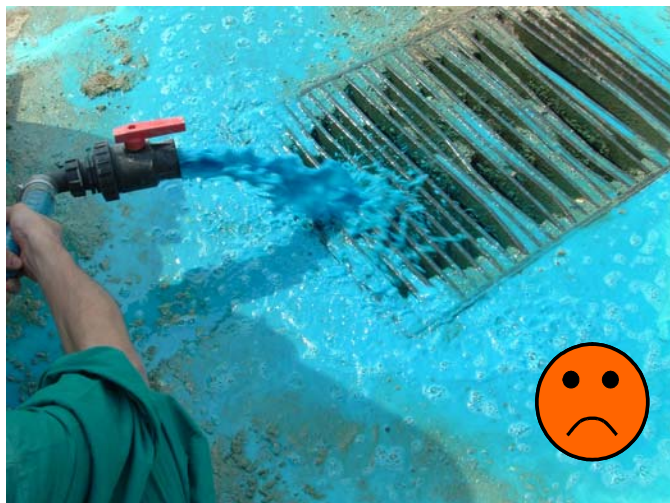
Fig. 65 - Esempio di NON corretto smaltimento della miscela residua e dell'acqua di lavaggio tramite tombino collegato alla rete fognaria.
