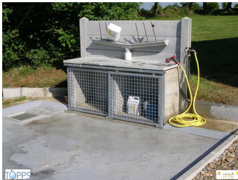
Figura 15 – Esempio di area attrezzata pavimentata e dotata di sistema per la raccolta delle acque contaminate da agrofarmaci.
