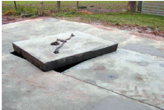
18–19 ábra: 4000 literes PE puffer tartály a felszín felett, illetve egy 5000 literes beton puffer tartály, amely felett töltő- és tisztítóhely került kialakításra. Az esővíz elvezetés elkülönítetten történik. (Forrás: pcfruit).
