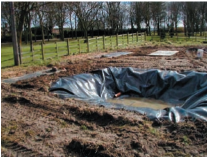
25–26 ábra: A beton helyett a bioágyat műanyaggal is lehet szigetelni, EPDM (balra, Forrás: ADAS) és PE tartályok (jobbra, Forrás: Mybatec)
