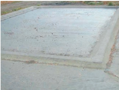
16–17. ábra: Különálló beton töltő- és tisztítóhelyek, ahol a szennyezett folyadék egy beton vályún (bal oldal), illetve folyadékélvezető rácson keresztül jut a biotisztító rendszerbe. (Forrás: ADAS).
