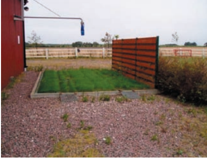
28–29 ábra: Fűves réteg a közvetlenül terhelt bioágy felületén (balra, Forrás: Visavi) és Carex fajok egy bővített bioszűrő utolsó egységében (jobbra, Forrás: pcfruit)
