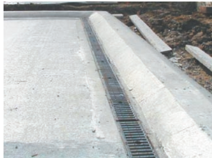
16–17. ábra: Különálló beton töltő- és tisztítóhelyek, ahol a szennyezett folyadék egy beton vályún (bal oldal), illetve folyadékélvezető rácson keresztül jut a biotisztító rendszerbe. (Forrás: ADAS).
