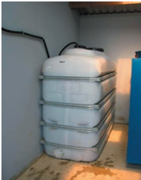
18–19 ábra: 4000 literes PE puffer tartály a felszín felett, illetve egy 5000 literes beton puffer tartály, amely felett töltő- és tisztítóhely került kialakításra. Az esővíz elvezetés elkülönítetten történik. (Forrás: pcfruit).
