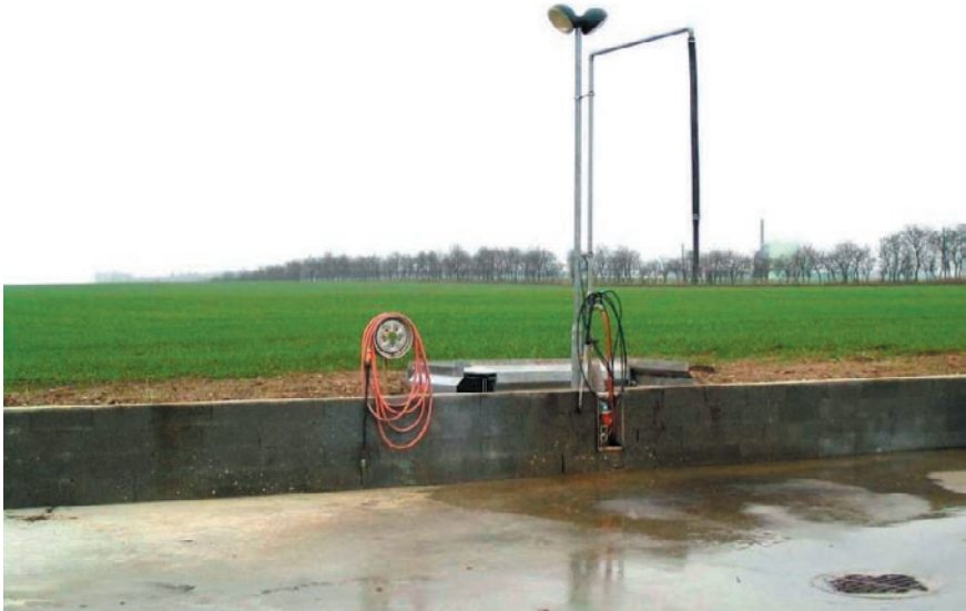
15. ábra: Különálló, betonozott töltő és tisztítóhely, megfelelő eszközökkel. A szennyezett víz a biotisztító rendszerbe kerül elvezetésre (Forrás: Bayer CropScience).
