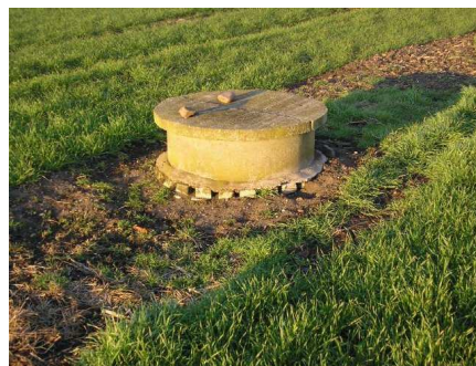
Fig. 8 – Esempio di pozzo correttamente coperto.
