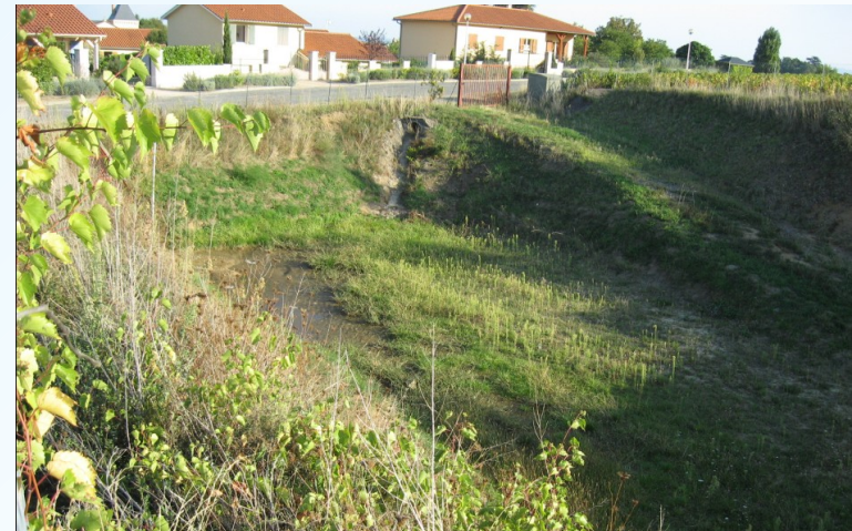
Storm basin (Beaujolais)
