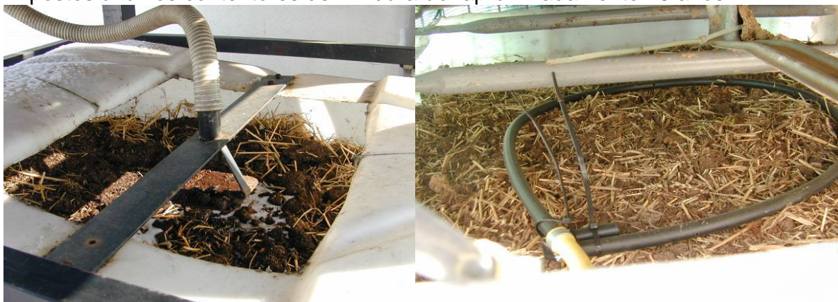
Fig. 21 & 22: Distribuindo o líquido contaminado sobre a superfície por meio de placa de metal (esquerda, fonte CRAw) ou mangueira circular perfurada (direita, fonte pcfruit).
