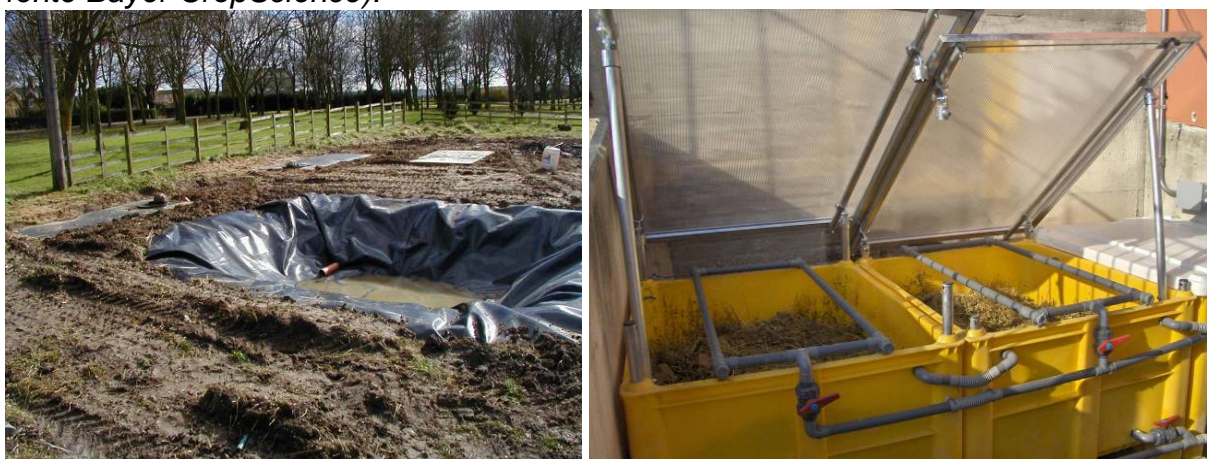
Fig. 25 & 26: Como alternativa ao betão, biobed pode ser impermeabilizada com plástico EPDM (esquerda, fonte ADAS) e contentores de PE (direita, fonte Mybatec).
