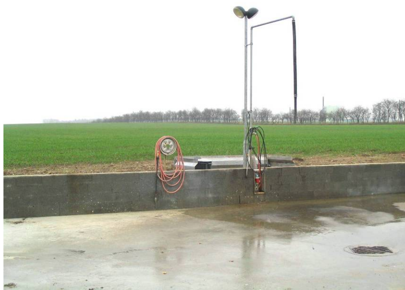
Fig. 15: Zonas de enchimento e limpeza, com respectivo equipamento, feitas em betão, que drenam os líquidos contaminados para o sistema de purificação (fonte: DAAS).
