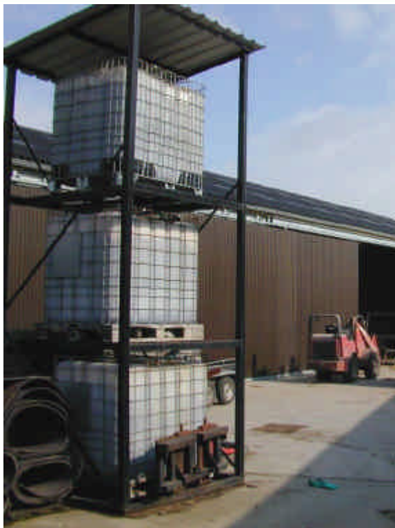
Fig.4: Biofilter (fuente: CRAw)
