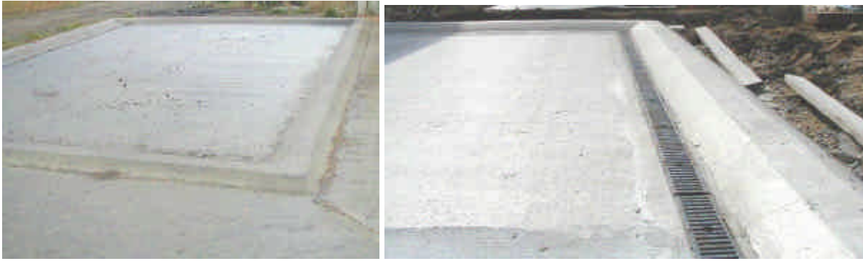
Fig. 16 y 17: Zonas independientes de llenado y limpieza que permiten la recogida y gestión de las aguas sucias. Zona impermeable de hormigón (izquierda) o rejilla de drenaje (derecha) (fuente: ADAS).
