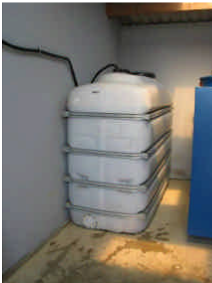
Fig. 18 y 19: Ejemplo de depósito de auxiliar de polietileno de 4000 litros de capacidad y depósito enterrado de hormigón de 5000 litros, cercanos ambos a la zona de llenado y limpieza y con válvula de separación del agua de lluvia (fuente: pcfruit).
