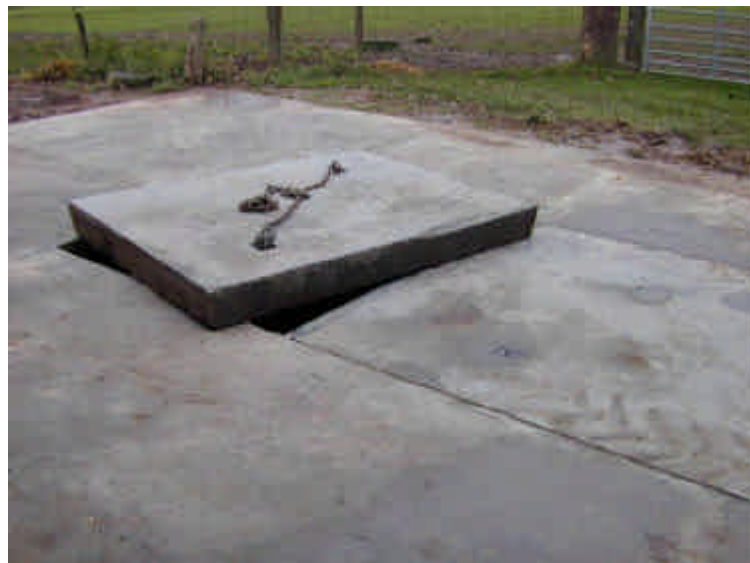
Fig. 18 y 19: Ejemplo de depósito de auxiliar de polietileno de 4000 litros de capacidad y depósito enterrado de hormigón de 5000 litros, cercanos ambos a la zona de llenado y limpieza y con válvula de separación del agua de lluvia (fuente: pcfruit).
