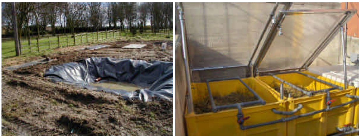
Fig. 25 y 26: La utilización de plásticos es una alternativa al hormigón para garantizar la impermeabilidad del biobed (izquierda, fuente ADAS). El PE es ampliamente utilizado en la construcción de biofilters (derecha, fuente Mybatec).
